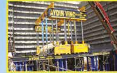
Gantry Sistemle 450 Ton TMB'nin tünelden çıkarılması
