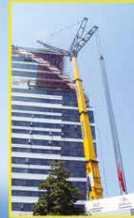
Hilton Otel'de 100m'ye cam silme vinci montajı
