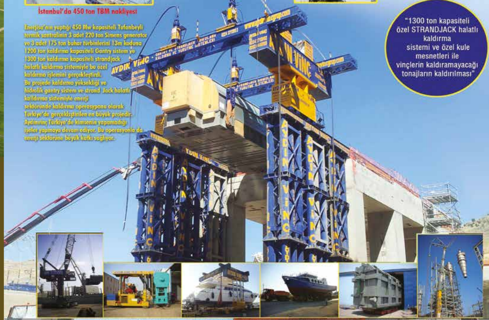
Gantry Sistemle 450 Ton TMB'nin tünelden çıkarılması
