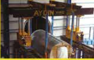
Gantry Sistemle 8m kaideye Siemens Genaratör montajı
