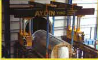
Gantry Sistemle 8m kaldeye Siemens Genaratör montajı
