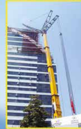
Hilton Otel'de 100m'ye cam silme vinci montajı
