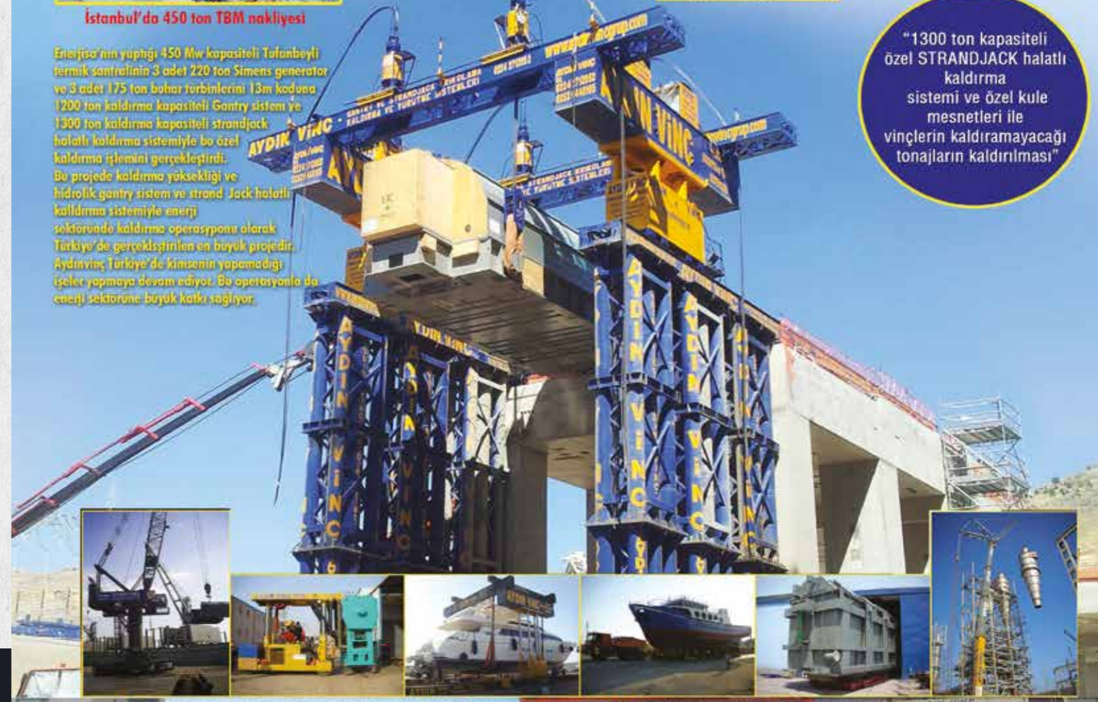
Gantry Sistemle 450 Ton TBM'nin tünelden çıkarılması
