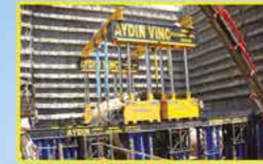
Gantry Sistemle 450 Ton TBM'nin tünelden çıkarılması
