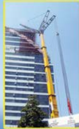
Hilton Otel'de 100m'ye cam silme vinci montajı
