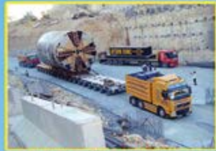
Istanbul'da 450 ton TBM nakliyesi
