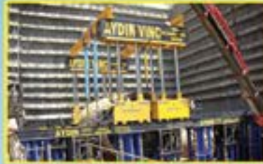
Gantry Sistemle 450 Ton TBM'nin tünelden çıkarılması
